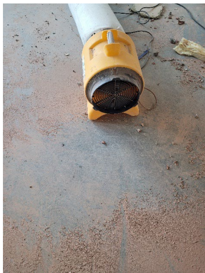
Figur 10: Ventilasjonsvifte med tilhørende støvpose. FOTO: STAMI
