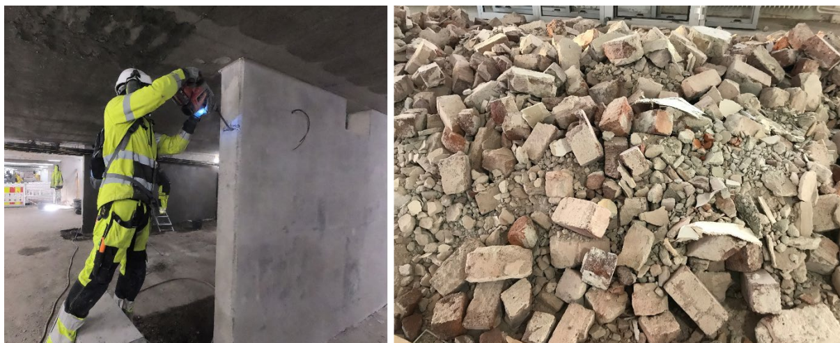
Figur 1: Typiske arbeidsoppgaver som det ble målt på: pigging (a), Rydding og kasting av bygningsavfall (b). FOTO: STAMI
